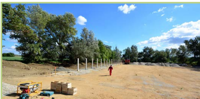
Budovanie nového zberného dvora
