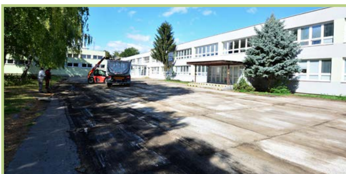
Realizácia asfaltu na školskom dvore
