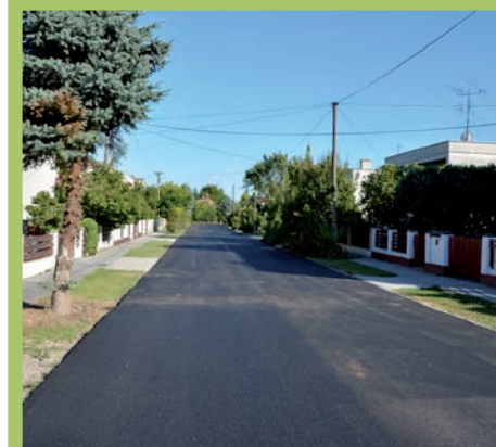
Nový asfalt na Mládežníckej ulici
