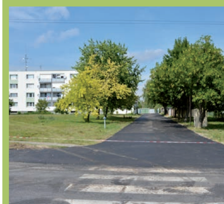
Nový asfalt pri bytovkách so súpisným číslom 34 a 35 + oprava prepadnutej kanalizácie pri týchto bytovkách
