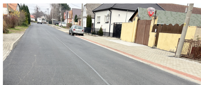
chodník a obnova krytu vozovky na Nešporovej ulici
